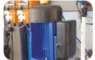
Pompa ad asse verticale inox.
