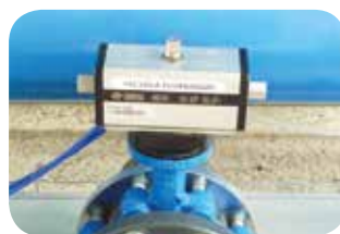
E.V. flussaggio acqua pulita (opzionale).
