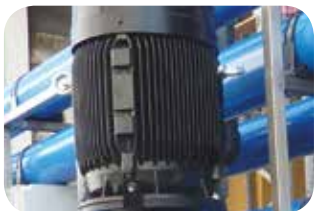
Pompa ad asse verticale inox.
