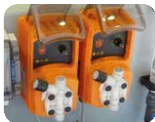
Pompe dosatrici per additivi di pre-trattamento
