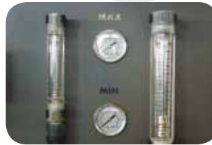
Flussimetri Concentrato e Permeato.
