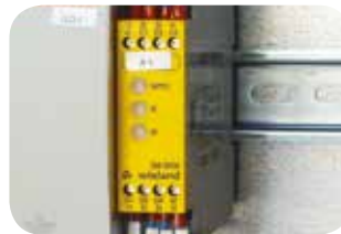
Relè di sicurezza a norma EN60204-1.
