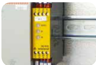
Relè di sicurezza a norma EN60204-1.
