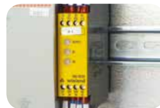
Relè di sicurezza a norma EN60204-1.
