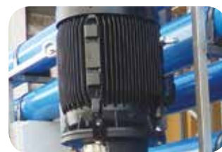
Pompa ad asse verticale inox.
