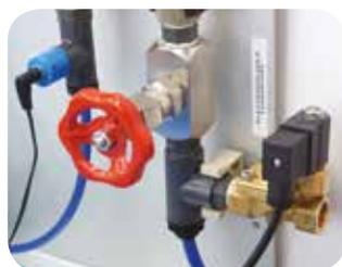
Valvola a spillo inox ed elettrovalvola di flussaggio.
