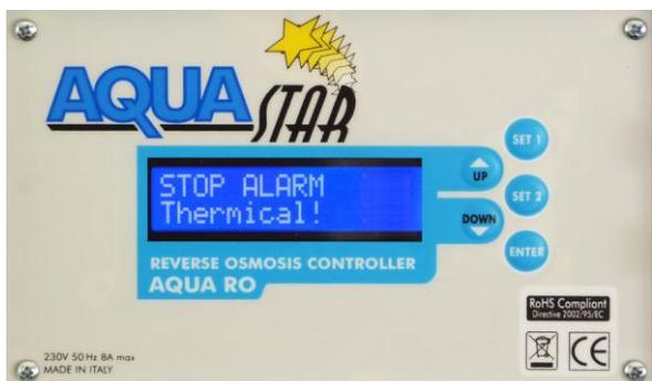
5. *Allarme termica PTC pompa alta pressione. Si innesca per mezzo della pastiglia PTC inserita sul motore della pompa. L'impianto si ferma immediatamente; per riavviarlo agire manualmente sull'interruttore magnetotermico a monte del quadro;*
