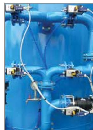
Batteria di valvole a farfalla c/attuatori pneumatici.
