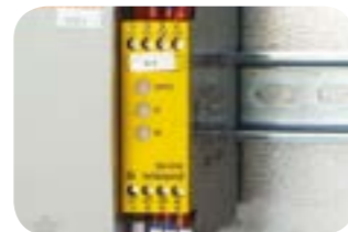
Relè di sicurezza a norma EN60204-1.
