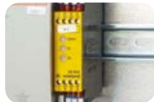
Relè di sicurezza a norma EN60204-1.
