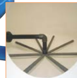
Dettaglio verniciatura interno serbatoio
