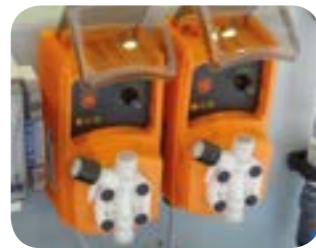
Pompe dosatrici per additivi di pre-trattamento
