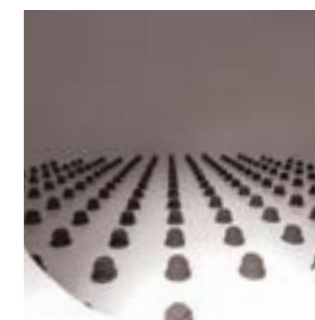
Plancher à crépines filtrantes (Adoucisseurs RPP)
