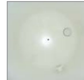
Détail de la peinture interne du réservoir
