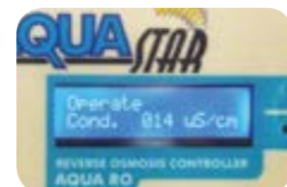
Automate programmable avec conductivimètre pour contrôler la qualité du perméat.
