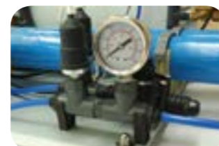
Groupe de pressostats; minimum, maximum et manomètre.
