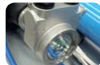
Groupe de pressurisation avec pompe à palettes inox.
