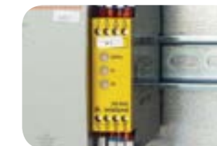
Relais de sécurité conforme à la norme EN60204-1.
